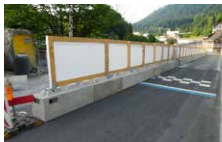
Baustellen-Absperrungen und -Einfassungen
