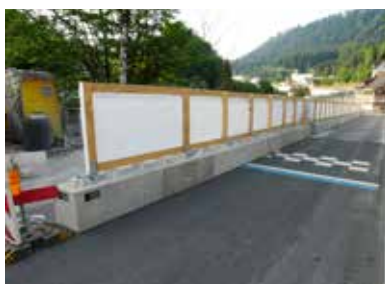
Baustellen-Absperrungen und -Einfassungen
