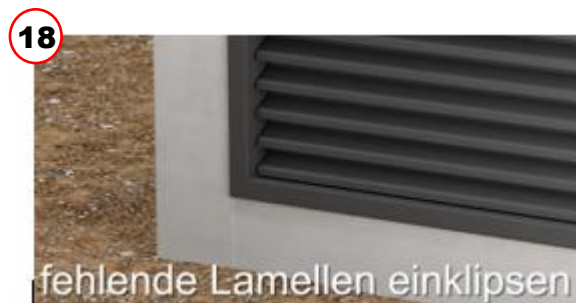
Die fehlenden Lamellen montieren
