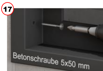
Lüftungsgitter mit 5 x 50 mm Betonschrauben verankern
