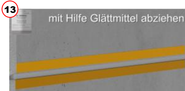
Die Fuge mit Hilfe des Glättmittels abziehen
