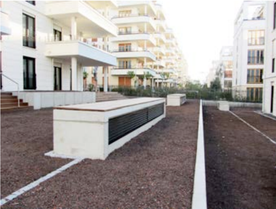
Bildunterschrift: Bild_SL_Europaviertel_1+2: Sonderlüftungsschächte zur Tiefgaragenentlüftung im Europaviertel in Frankfurt.
