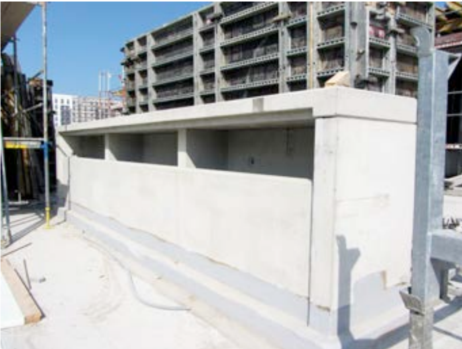
Bildunterschrift: Bild_ SL_Lichtschacht_Gefälle: Überbreiter Lichtschacht mit Gefälle und vorinstallierter Schiene für Gitterrostauflage.
