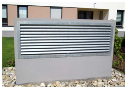
❖❖❖ Sonderlüftungsschächte zur Tiefgaragenentlüftung im Europaviertel in Frankfurt. ❖❖❖
