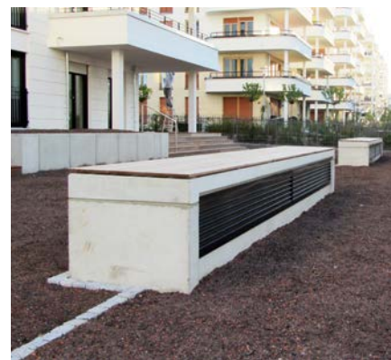
❖❖❖ Sonderlüftungsschächte zur Tiefgaragenentlüftung im Europaviertel in Frankfurt. ❖❖❖
