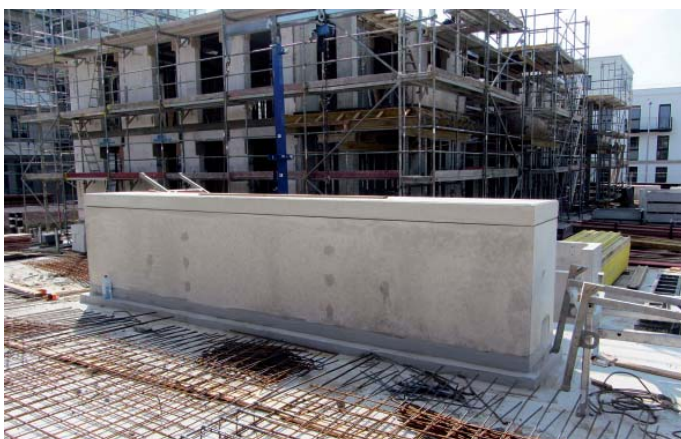
Die in Form, Größe und Höhe werksseitig gefertigten Unikate sind die wirtschaftliche Lösung, um Kosten bei Arbeit und Schalung einzusparen
