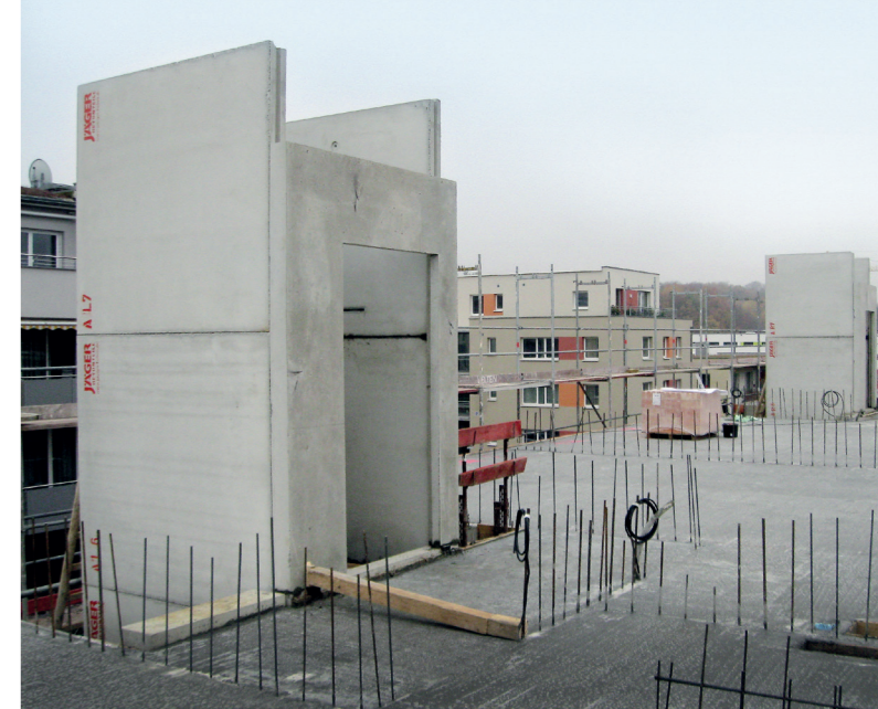
Aufzugsschächte aus Präzisions-Betonfertigteilen bieten extrem kurze Bauzeiten und günstige Kostenkalkulationen. Wie bei einem Bausatz von Lego lassen sich die einzelnen Schachtelemente denkbar einfach und passgenau zusammenfügen
