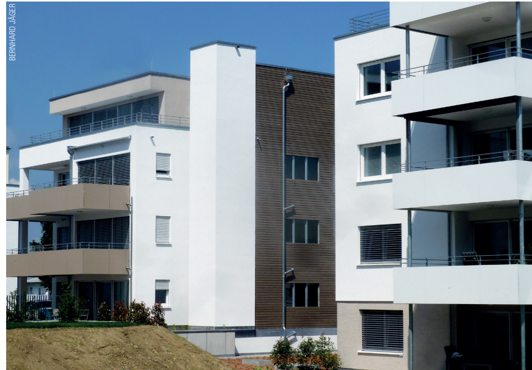
Außenseitig angebrachte AFZ-Aufzugsschächte lassen sich architektonisch ansprechend umsetzen, wie das Bauobjekt von Manfred Löffler Wohn- und Gewerbebau in Überlingen zeigt.
