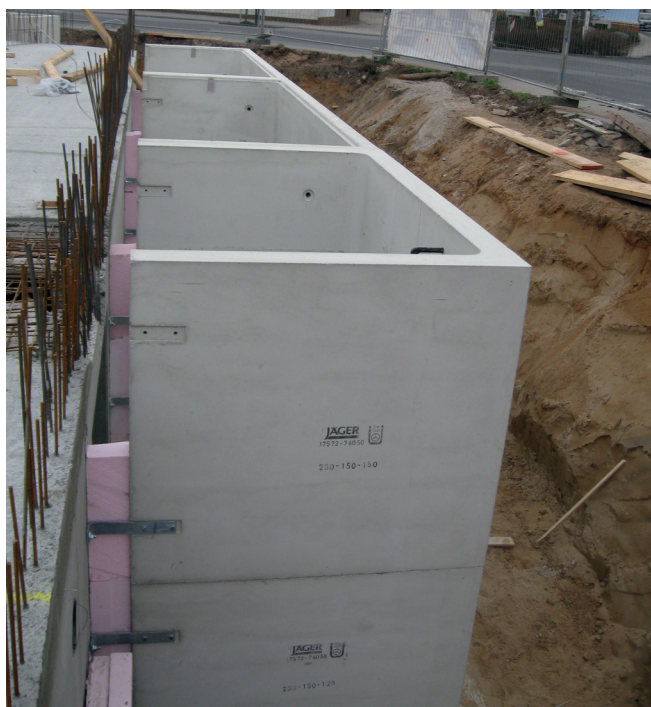
Lichtschachtband mit einer Gesamtlänge von 9 m und Höhen über 3 m, die einzelnen Teile sind bis zu 3,30 m breit.
