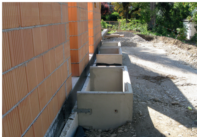
Standardisierte Lichtschächte für ein Mehrfamilienhaus
