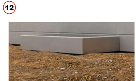
Die Hinterfüllung des Schachtes hat mit nicht bindigem Material (z.B. Kies) zu erfolgen
