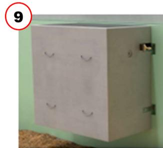
Nach der Montage sind alle Befestigungsteile mit einem bauseitigen Anstrich auf Bitumenbasis zu versehen.
