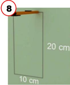
Ausschneiden der Dämmung im Auflagebereich der Winkellasche  $x = \text{ca. } 10 \times 20 \text{ cm}$ .
