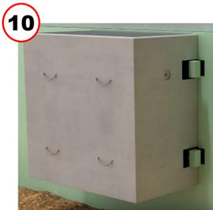
Nach der Montage des Lichtschachts das ausgeschnittene Dämmstoffteil wieder in den Ausschnitt eindrücken oder die Aussparung mit Schaum ausspritzen.
