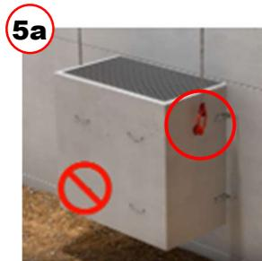
5a Lichtschacht an den werkseitig eingebauten Gewindehülsen mit zulässigen Versetzmittel an das Hubgerät anhängen.
