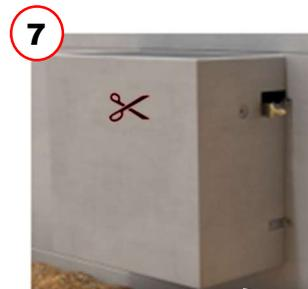
7 Nach der Montage sind die Abhebeschlaufen abzuschneiden und die Trennstellen, so wie alle Befestigungsteile mit einem bauseitigen **Anstrich auf Bitumenbasis** zu versehen
