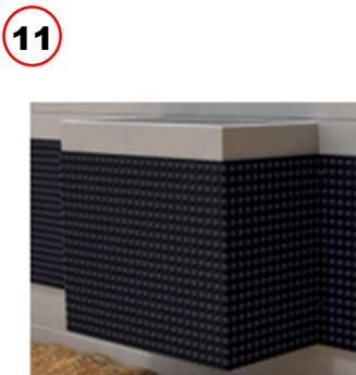
Alle Schächte sind unmittelbar nach der Montage mit einem Anfüllschutz zu versehen (Noppenfolie, o.ä.).
