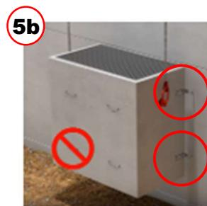
5b Lichtschacht mit angeschraubten Befestigungslaschen auf die Ankerbolzen anhängen.
