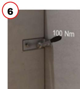
6 Abdeckscheibe, Unterslagscheibe aufstecken und Mutter mit Drehmomentschlüssel auf das erforderliche Drehmoment von  $x = 100\text{ Nm}$  festziehen. Alle Befestigungsmittel müssen angebracht sein, bevor der Schacht vom Hubgerät entsichert werden kann.
