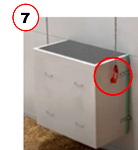
7 Lichtschacht an der werkseitig eingebauten Gewindehülsen mit zulässigen Versetzmittel an das Hubgerät anhängen.
