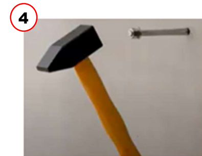
4 Ankerbolzen auf 99 mm Verankerungstiefe einschlagen.
