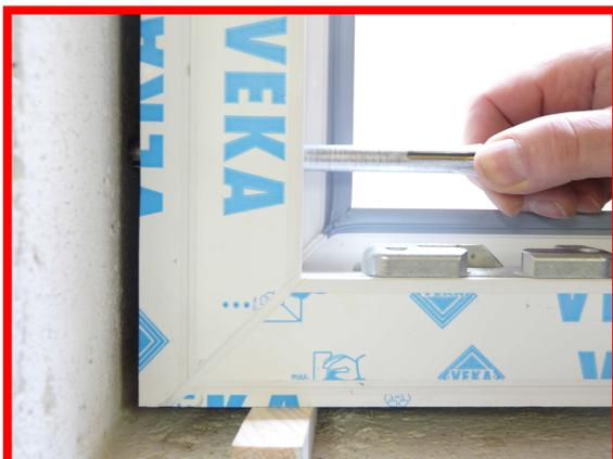
Fensterrahmen mit Betonschraube oder mit  $\varnothing$  10mm Fensterrahmendübel mit Ganzmetallhülse fixieren.
