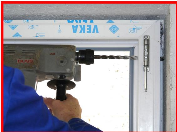
Fensterrahmen mit Mauerwerk abbohren [  $\varnothing$  6mm ].
