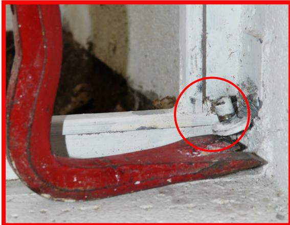
Bauseitige Metallscharniere und Verriegelungseinheit herausbrechen oder mittels Trennschleifer entfernen.
