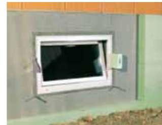
Aufgestecktes UNIFIX KOMBI-Dämmstoffformteil
