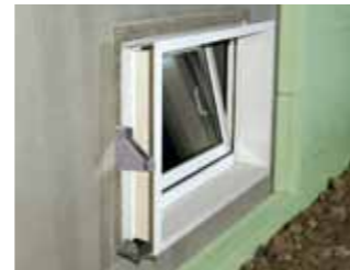
Montierte UNIFIX KOMBI-Leibungsblende. Befestigung nur bei eingesetztem Fenstereinsatz möglich
