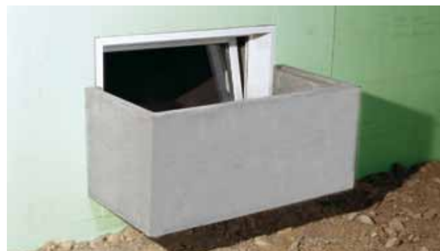
Montierter Eihängelichtschacht „D“
