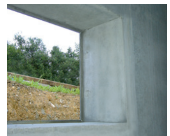
Die GFB-PROFI-Zarge schließt durch ihre exakten Kanten und Flächen absolut bündig mit der Kellerwand ab.
