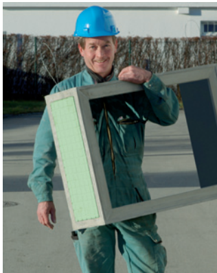
GFB-PROFI - Die leichtgewichtige Glasfaserbetonzarge lässt sich ohne Kranunterstützung versetzen.
